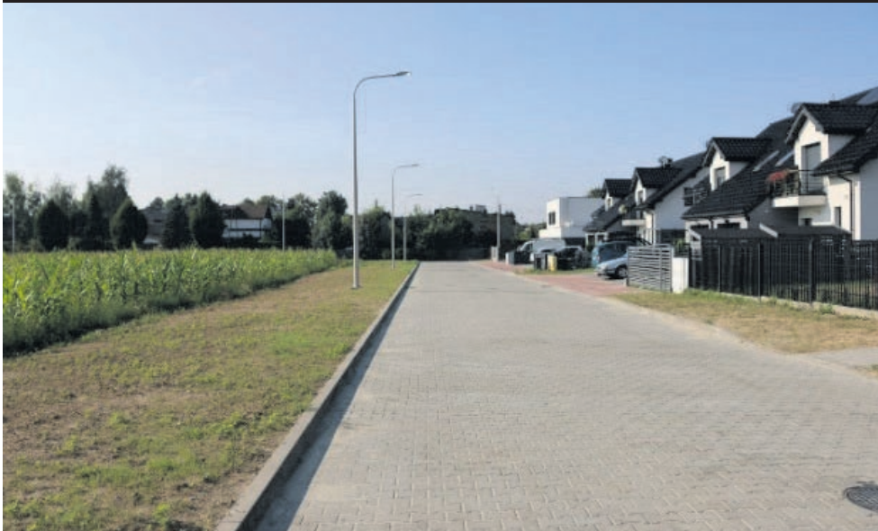
Ul. Jastrzębia po przebudowie.
